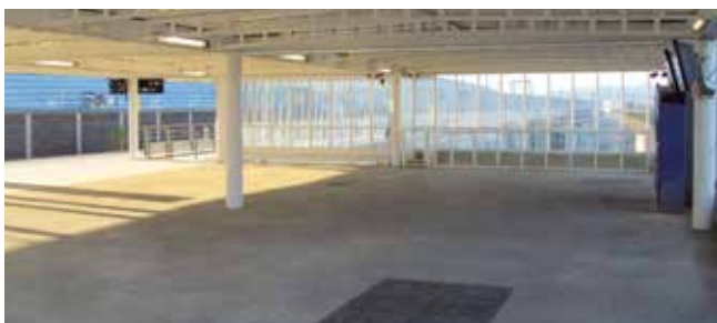
Terminal TER en gare d'Avignon TGV
