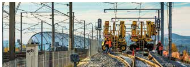
Travaux en gare d'Avignon TGV
